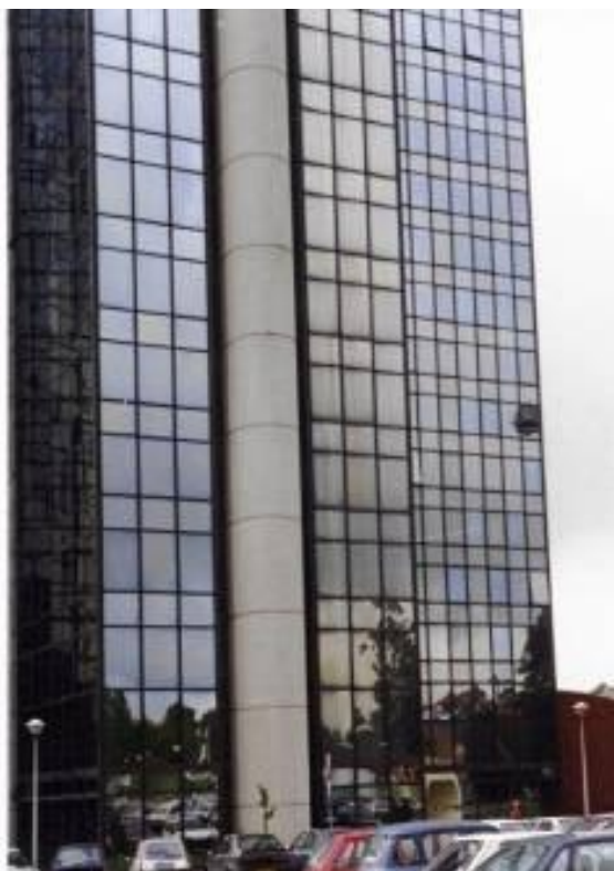
Tour Mercure en rénovation
