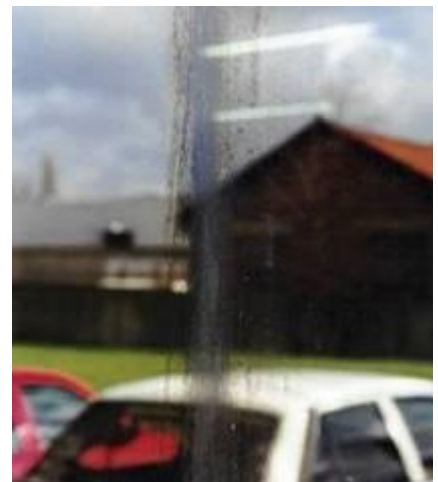
Coulure de béton sur un verre réfléchissant
